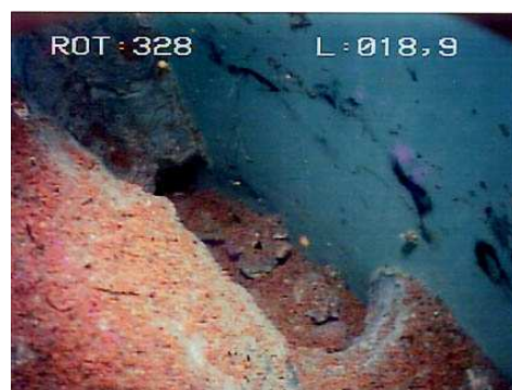
Photo6 : vue du fond de l'ouvrage, présence d'un bouchon de fond en béton
