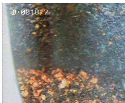
Photo3 : vue du fond de l'ouvrage
