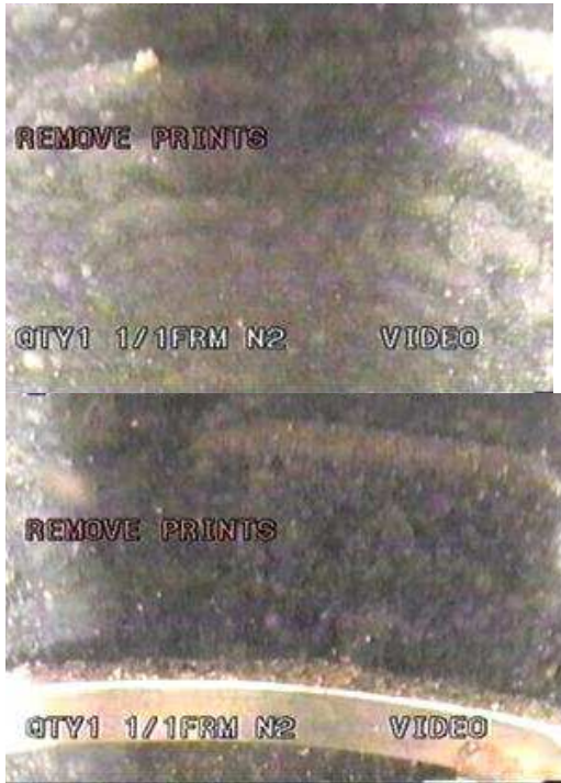
Vue des crépines type indéterminé avant nettoyage
