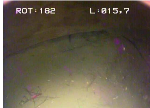
Vue du fond de l'ouvrage
